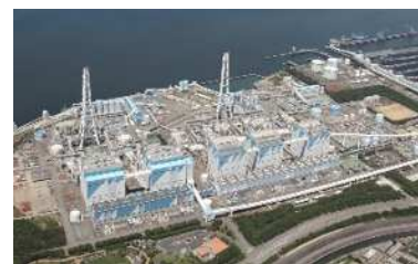
碧南火力発電所
